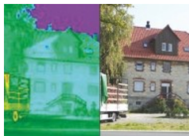
za termografiju u
