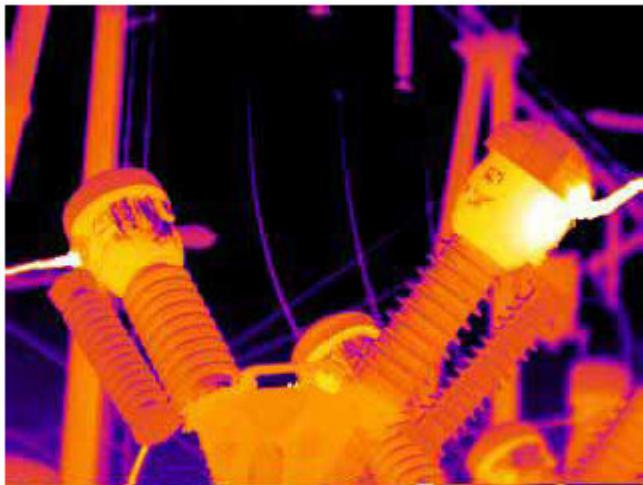
Na slici je prikazano prekomerno grejanje prouzrokovano velikom otpornošću, ili prekomernom jačinom struje, što prouzrokuje mnogo problema u elektroenergetskim sistemima. Infracrvena termografija nam omogućuje da vidimo ove nevidljive termičke znake predstojećih oštećenja, pre nego što strujno kolo postane toliko toplo da se dogodi ispad iz rada, ili eksplozija.
