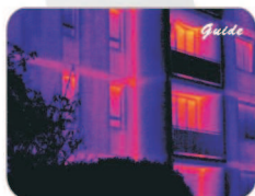
Ispitivanje strukture građevina
